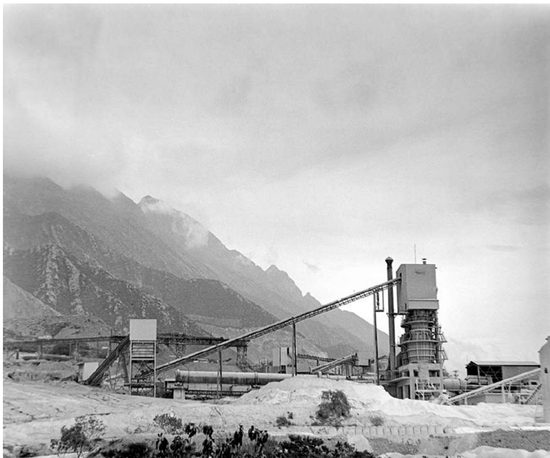
Imagen 2: Pedrera San Ángel, aún en funcionamiento al extremo poniente del cerro de las Mitras. Puede apreciarse el dispositivo de extracción de la roca caliza, las trituradoras y tolvas para convertirlas en arena fina, 2020.
