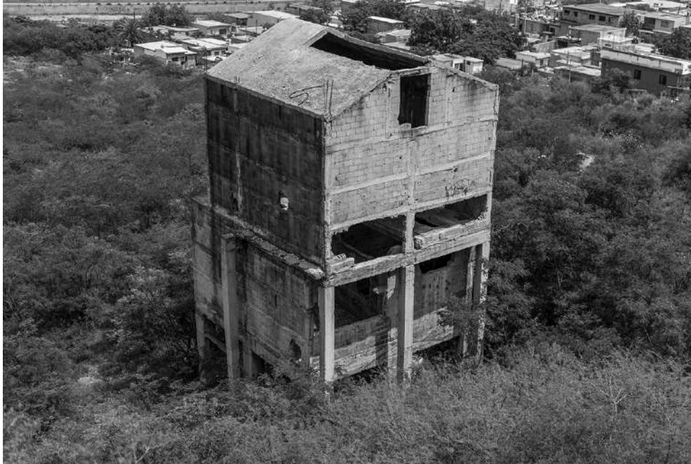
Imagen 8: Estas antiguas pedreras muestran aún las edificaciones funcionales de las estructuras donde albergaban las trituradoras, las bandas transportadoras y la tolva.
